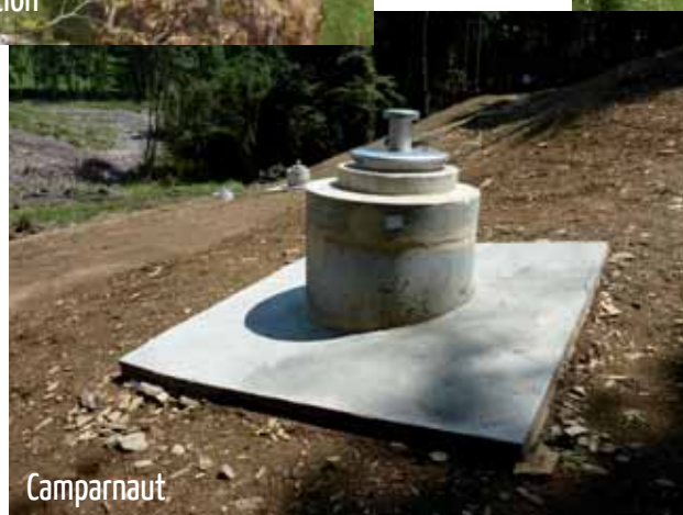
Réservoir construit dans les années 80
